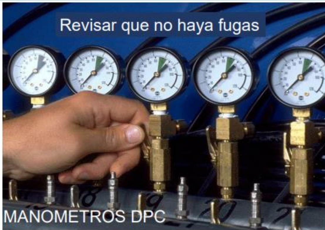
Figura 4.22 Manómetros de presión de la cámara.
